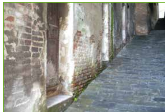
Deformeren van steen en voegen
