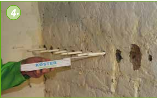
De Köster Capillairstaven worden zo verwerkt, dat de uiteinden 7 cm uitsteken.
