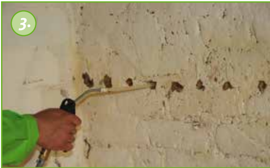
De boorstof uit de gaten verwijderen.
