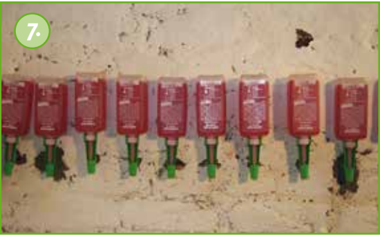
De drukloze injectie met Köster Crisin® 76 Concentraat begint met de plaatsing van de flessen.
