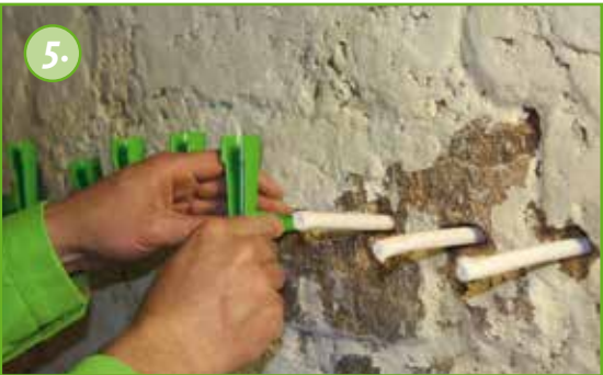
De Köster Muurtap zo monteren dat de capillairstaven tot in het voorraaddeel reiken.
