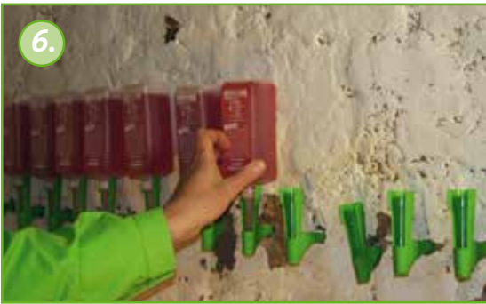
De Köster Crisin® 76 Concentraat flesjes worden vervolgens op de muurtap geplaatst.
