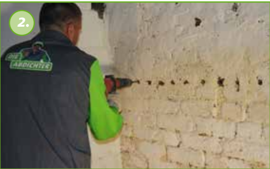
Gaten boren met een onderlinge afstand van 10 cm. Boordiepte in dit geval 40 cm (wanddikte 45 cm)
